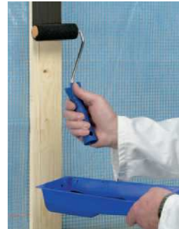
Příprava dřevěné konstrukce pomocí Primer SX Black
